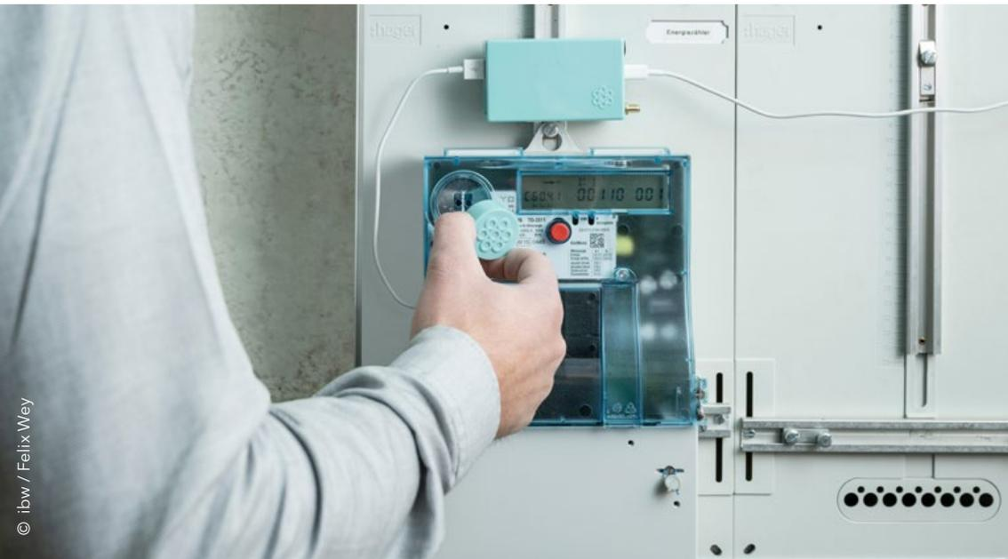
La passerelle aliunid avec capteur, installée sur un compteur électrique.
